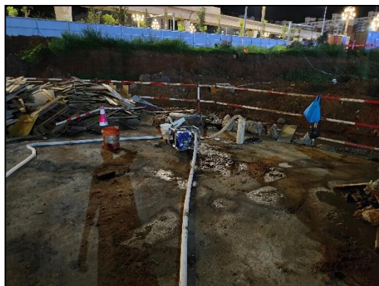
ZK1 抽水现场图
