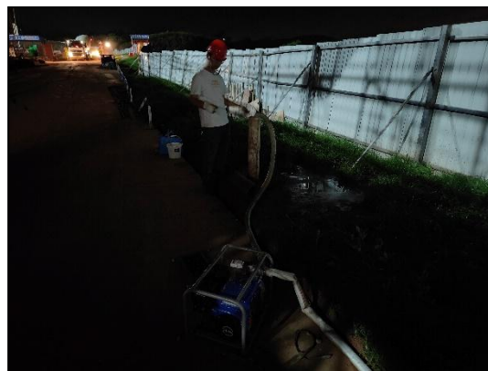
ZK5 抽水现场图
